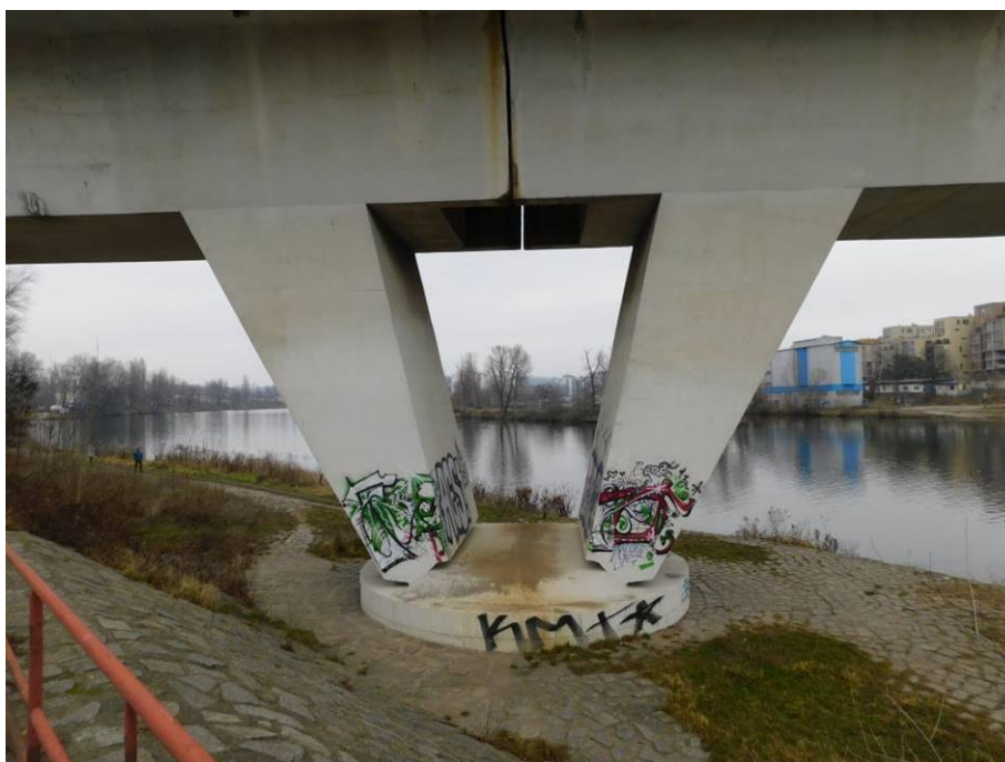
Uspořádání šikmých rámových stojek na základovém pilířovém bloku
